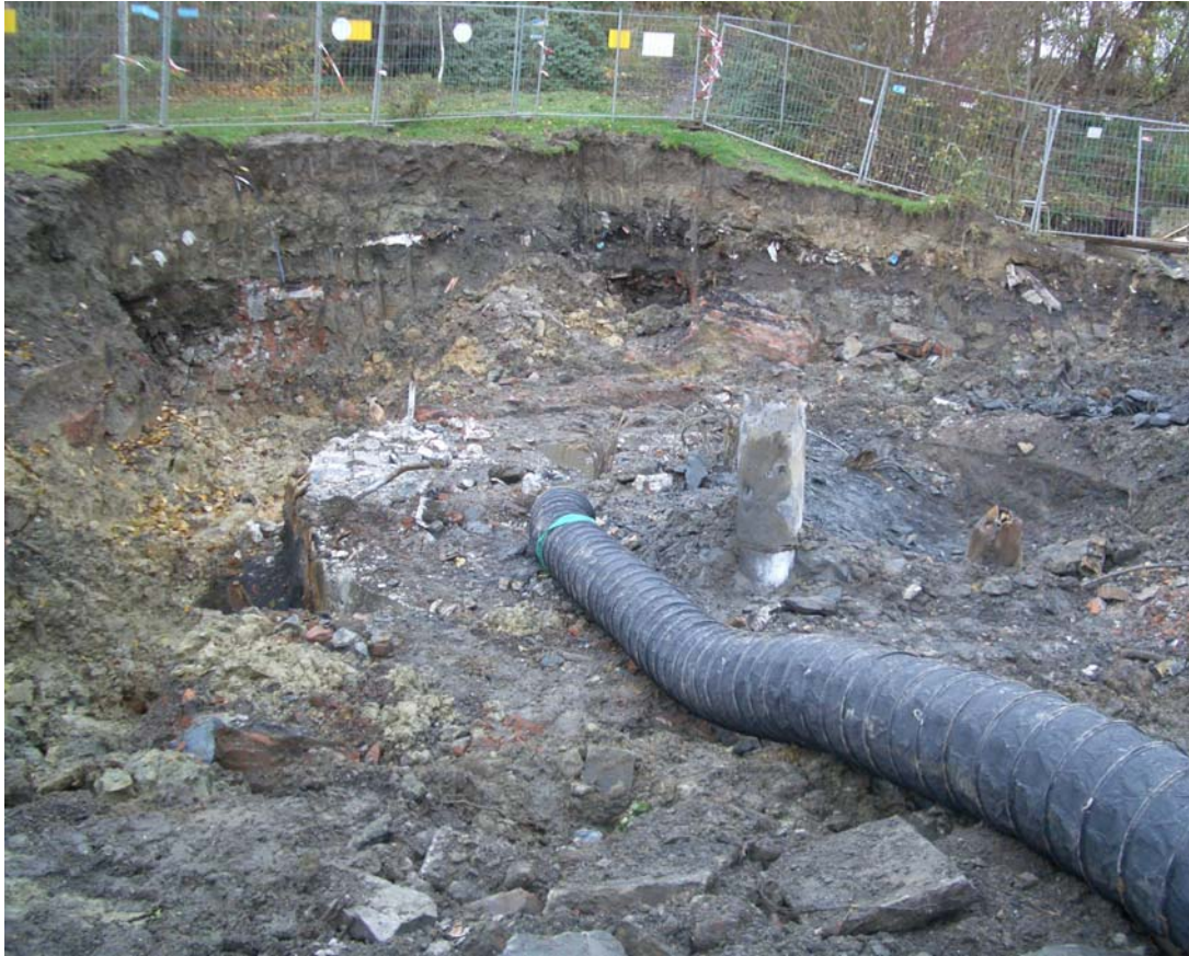
Abb.2 : Freigelegter Schachtkopf mit Sonderbewetterung
