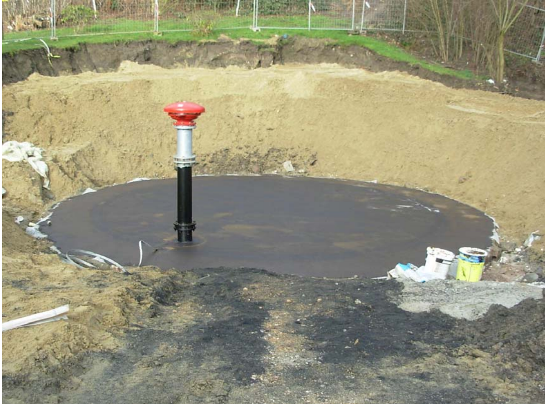
Abb.4 : Stahlbetonplatte mit Bitumendickbeschichtung (Entgasungseinrichtung nicht im Endausbau)
