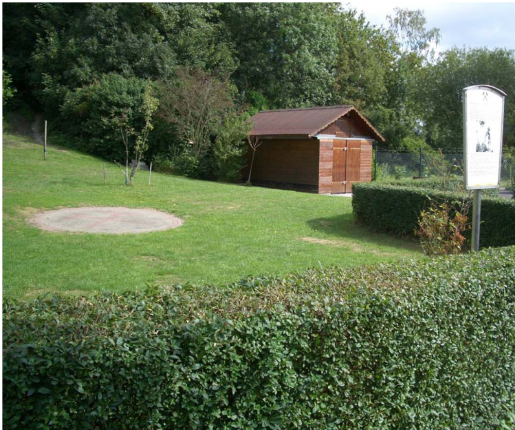
Abb.1 : Schacht Grillo 3 (Pflasterung), im Hintergrund Haus eines Kleingartenvereins
