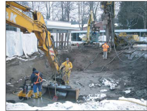
Foto: Schachtbau Nordhausen
