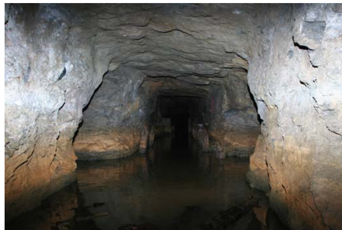
Abb.12 : Querschlag West am Streckenkreuz mit dem Reiche Empfängnis Stolln
