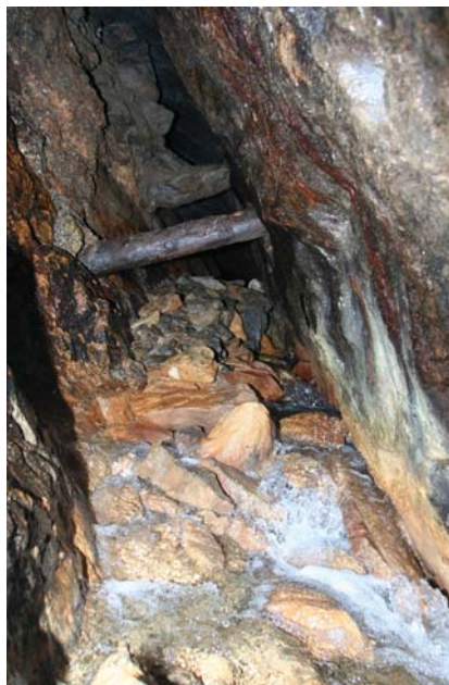
Abb.10 : Verbuch des Reiche Empfängnis Stollns bei ca. 1045 m – Blickrichtung Süden
