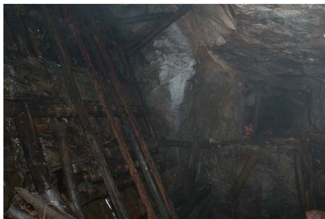
Abb.7 : Füllort Schacht Michaelis
