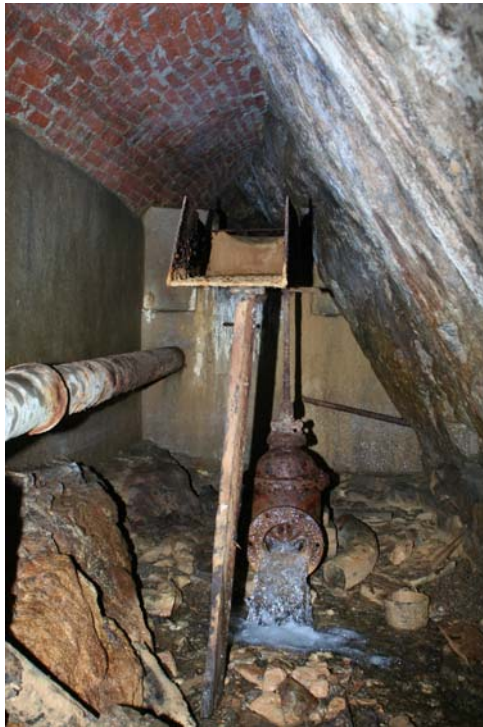
Abb.16 : Damm im Bierschnabel Stolln südlich des 3. Lichtlochs
