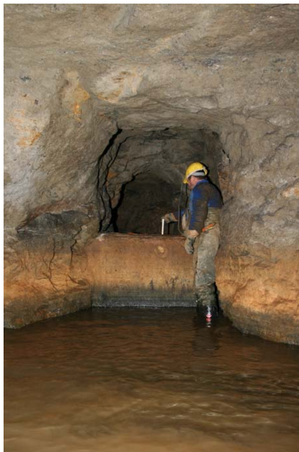
Abb.14 : Düker nördlich Querschlag West
