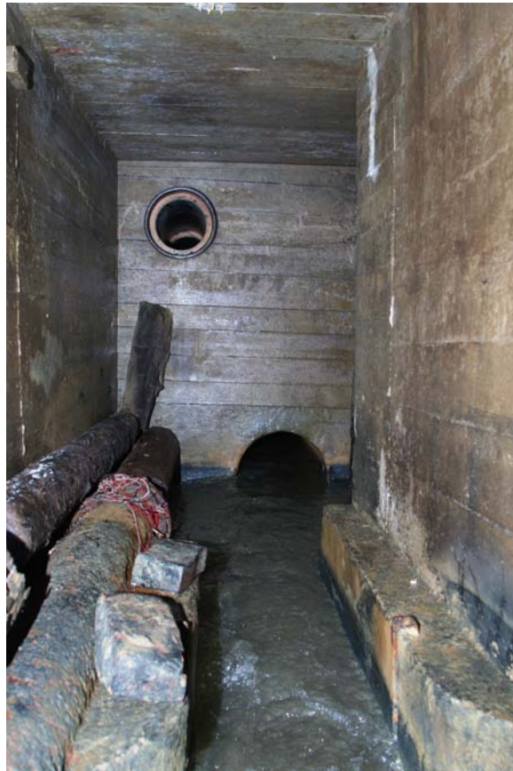
Abb.13 : Damm am Mundloch des Reiche Empfängnis Stollns mit Rohrdurchlässen
