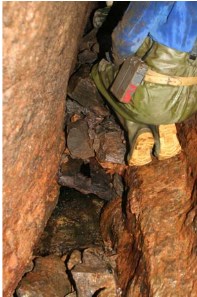
Abb.9 : Unter dem Tragwerk drainierende Wässer am Verbuch/Versatz des Reiche Empfängnis Stollns bei ca. 1090 m – Blickrichtung Norden
