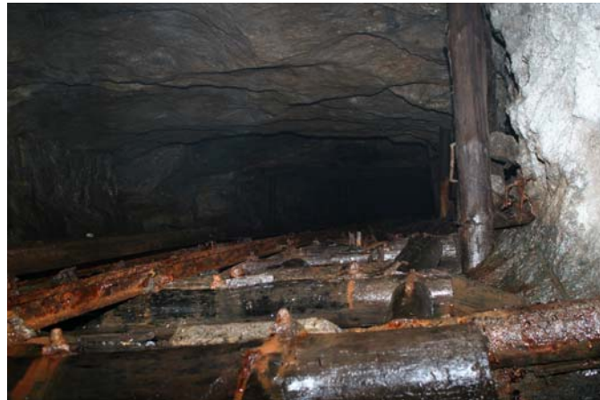
Abb.8 : Schachtröhre des Schachtes Michaelis
