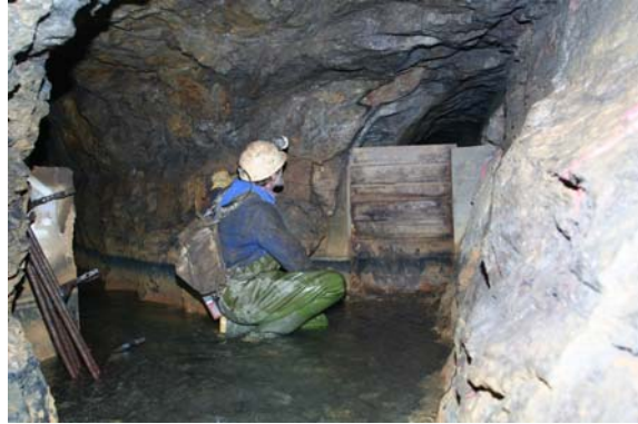
Abb.15 : Damm am Streckenabzweig Alter/Neuer Reiche Empfängnis Stolln
