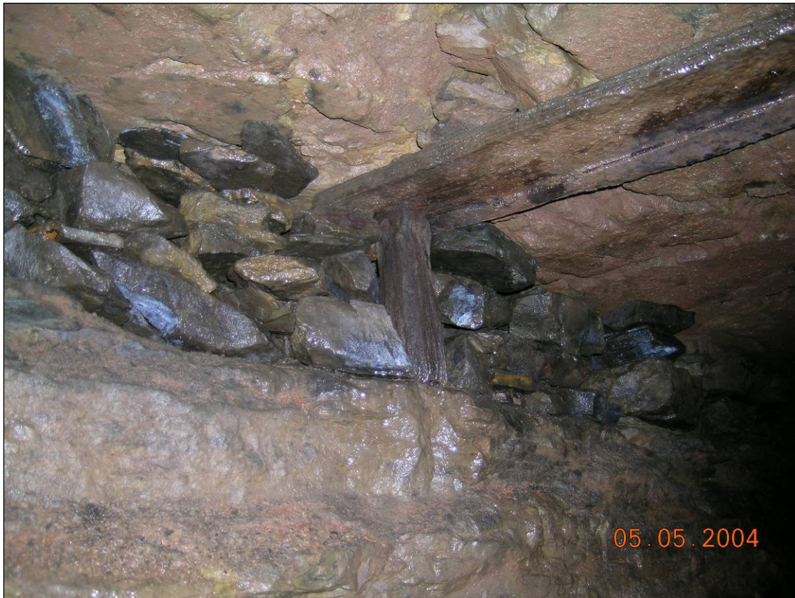
Abb.1 : Jakob Adolph Stollen mit seitlichen Kupferschieferabbauen im Firstbereich und altem Holzausbau
