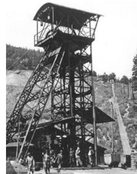
Anna-Wetterschacht, Bergbau Seegraben, Leoben
